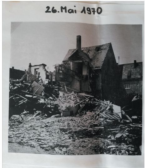
Abbruch des alten Pfarrheims (1970)
